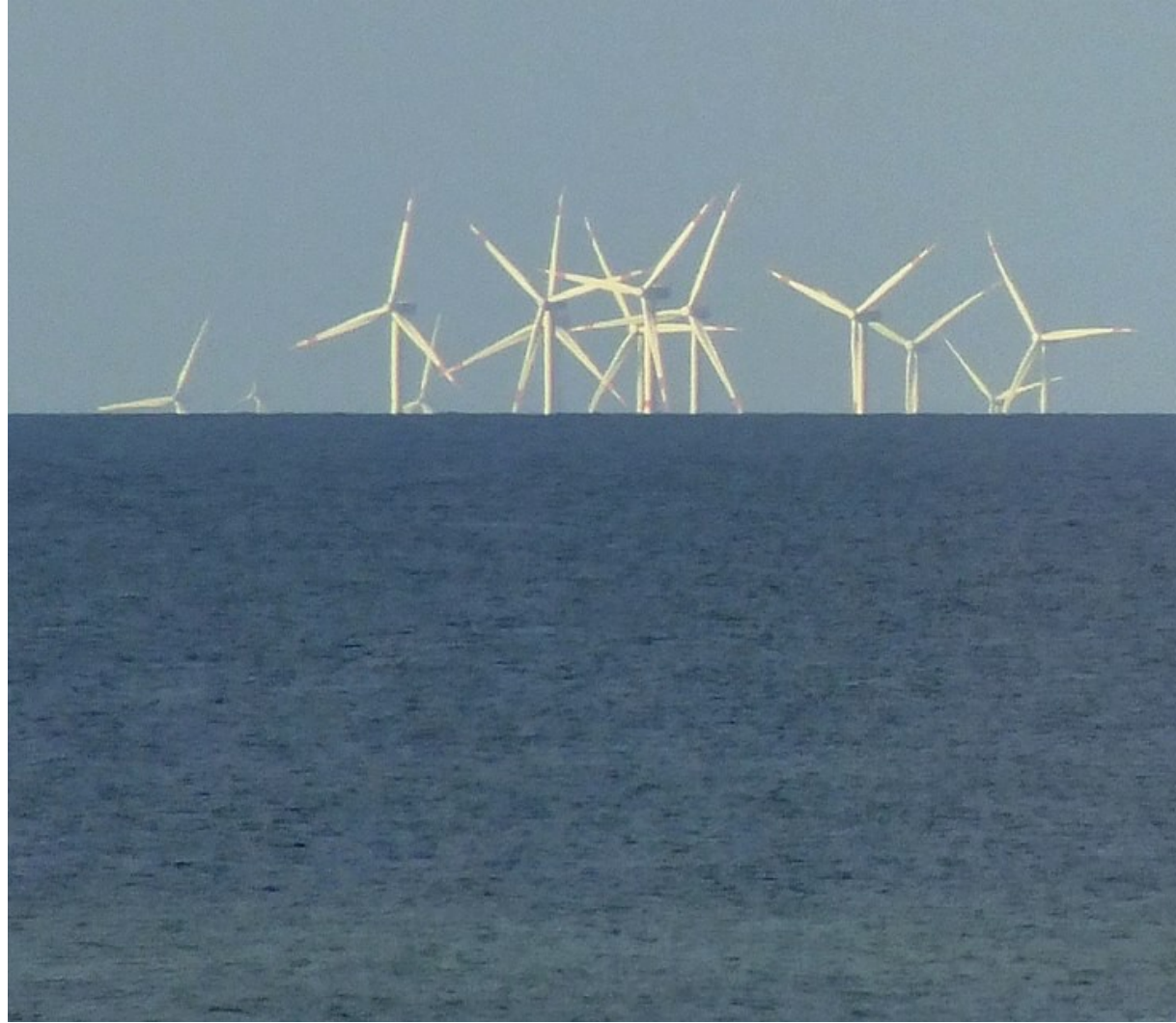
Parc éolien offshore de Thorntonbank, à 28 km des côtes belges en mer du Nord
